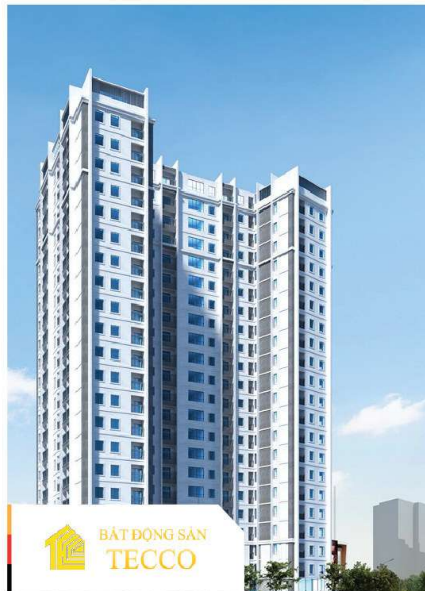
Dự án: Tòa nhà TECCO Chủ đầu tư: TECCO Vị trí: TP. Vinh - Nghệ An
