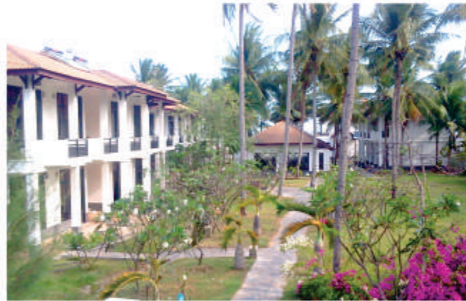
(Hình ảnh thực tế công trình)
